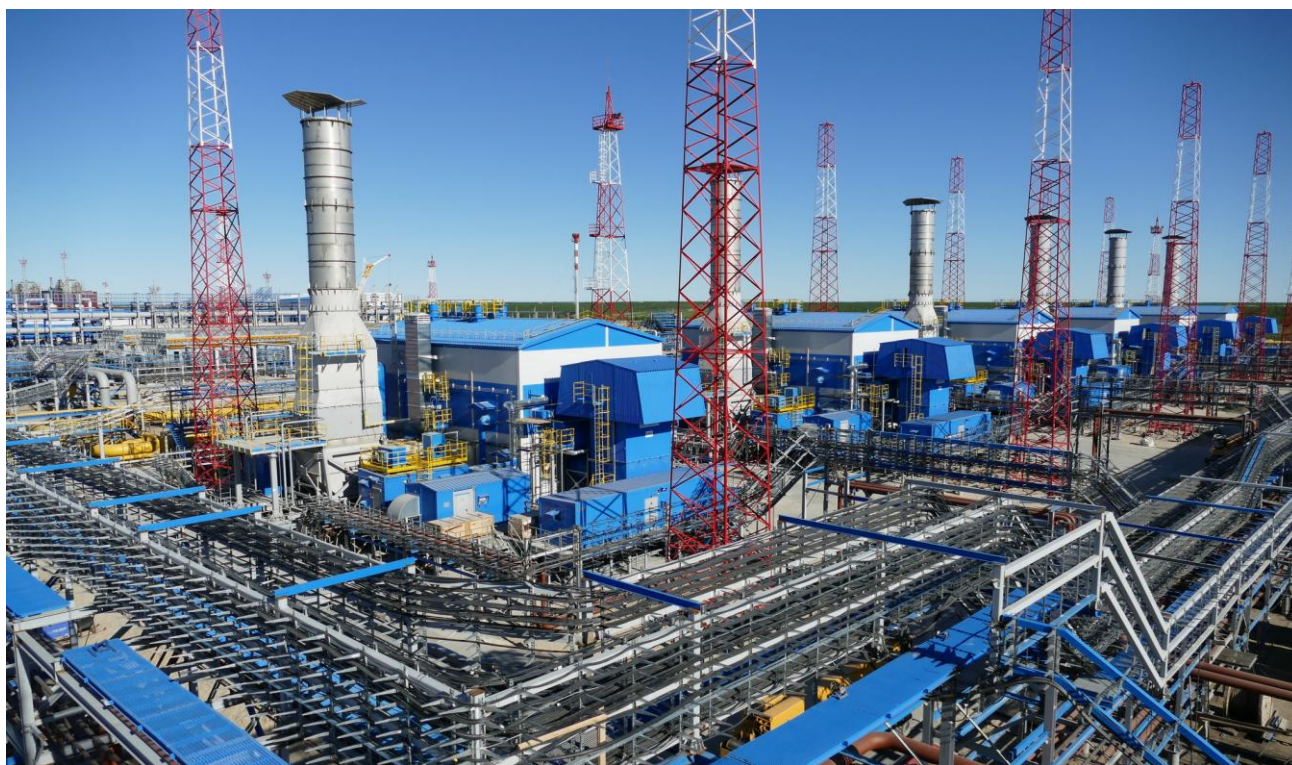
Фото №51. Дожимная компрессорная станция УКПГ-3С «Заполярная» (ОАО Газпром)
