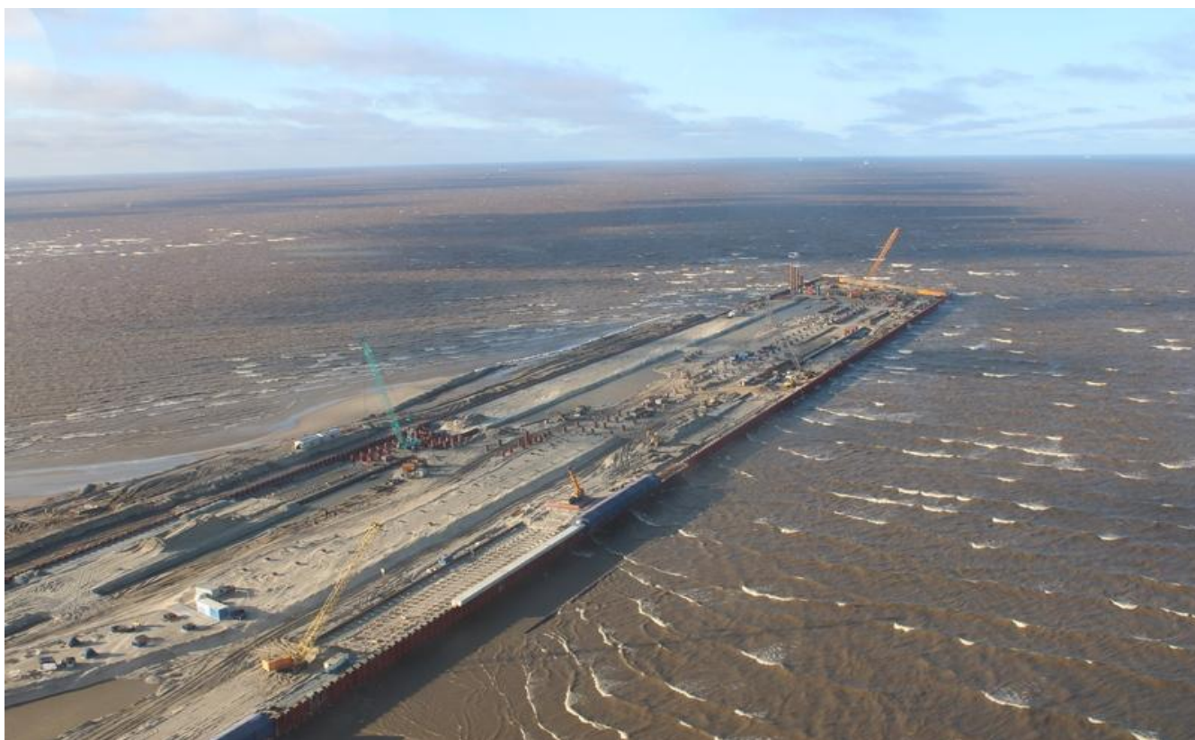
Фото №51. Строительство портовой инфраструктуры «ОК РУСАЛ» в Гвинее (Западная Африка).
