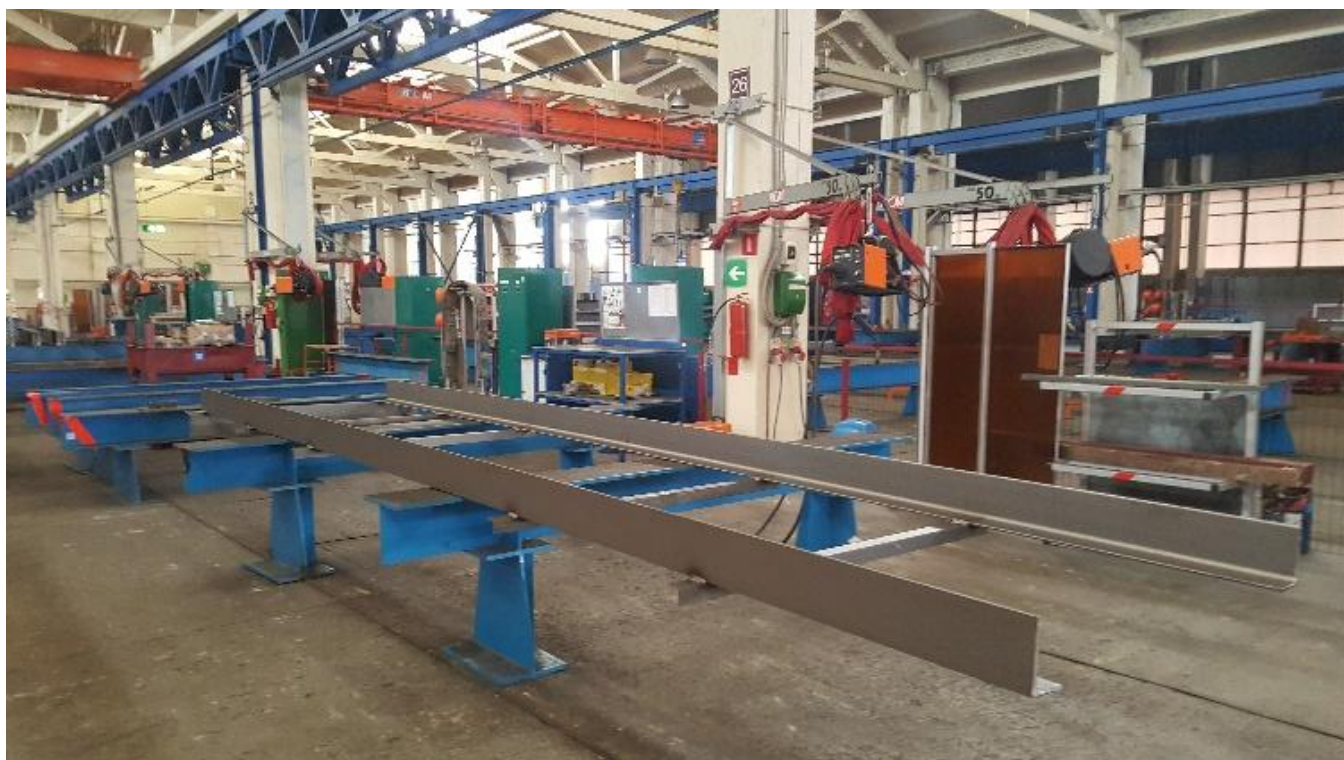
Фото №22. Сборка металлоконструкций осуществляется на передвижных ступелях.
