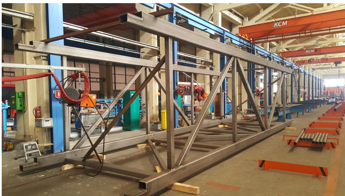
Фото №29. Секция башенного крана на обварке.
