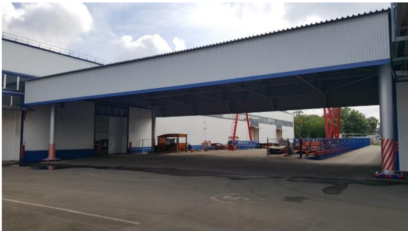
Фото №6. Крытая межцеховая галерея предохраняет намокание заготовок при их транспортировке в сборочно-сварочный цех
