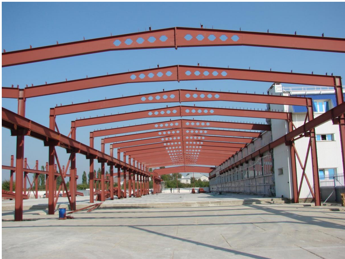
Фото №51. Металлоконструкции для производственного цеха.
