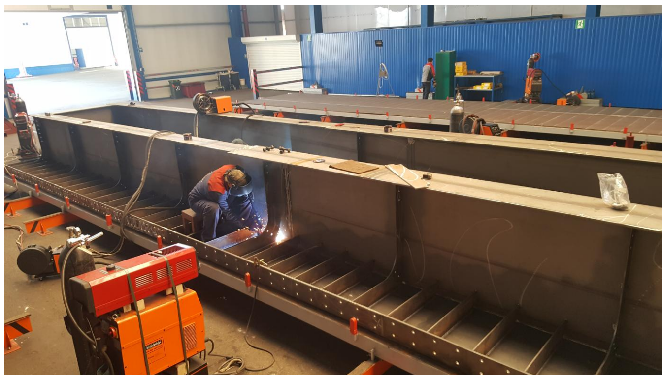
Фото №40. Для обварки рёбер жёсткости балок применяются сварочные каретки.
