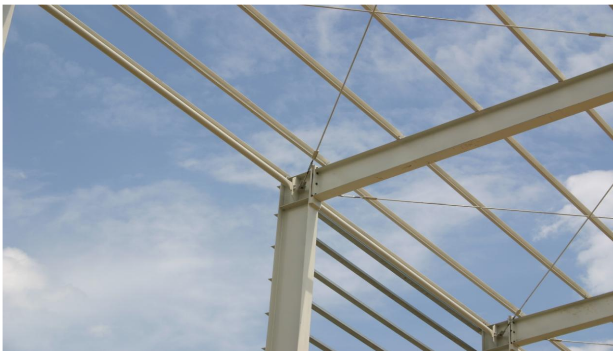
Фото №51. Металлоконструкции для 2-х доильно-молочных блоков и 8 коровников МТФ №3 ОАО ПЗ «Кубань» в г. Усть-Лабинске.
