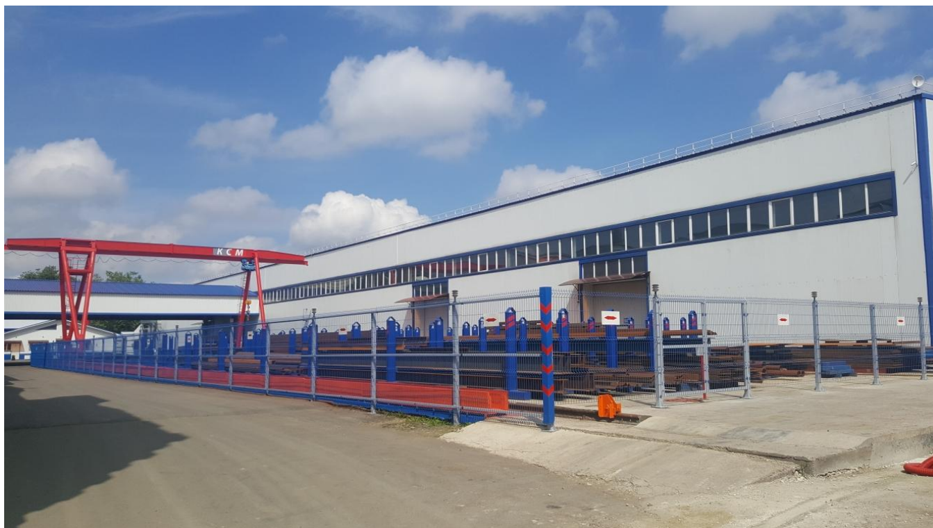
Фото №2. Общий вид склада металлопроката
