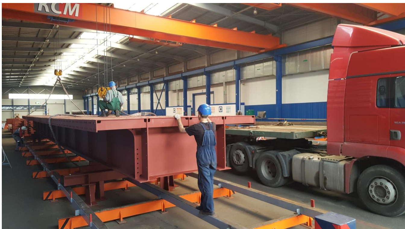
Фото №51. Строповка мостовой балки перед загрузкой в автотранспорт.
