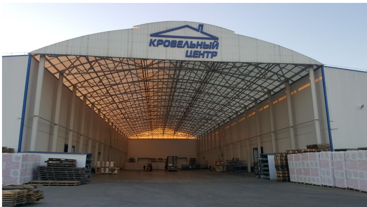
Фото №51. Склад ООО «Кровельный центр»
