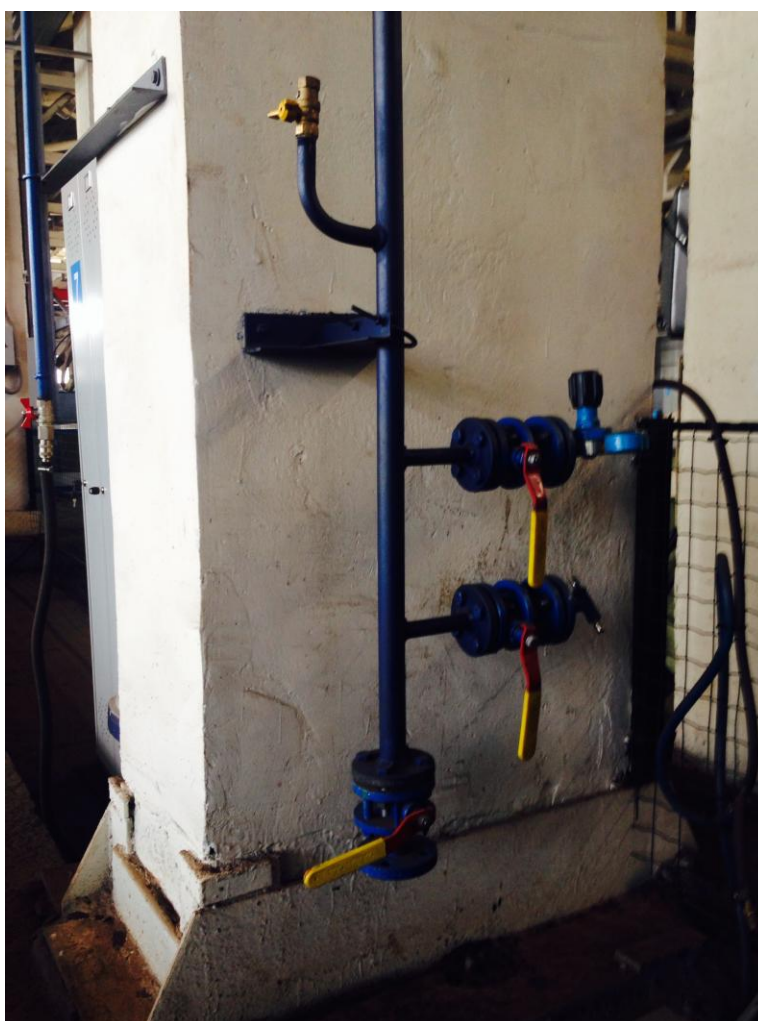
Фото №32 Система подачи газообразного кислорода.
