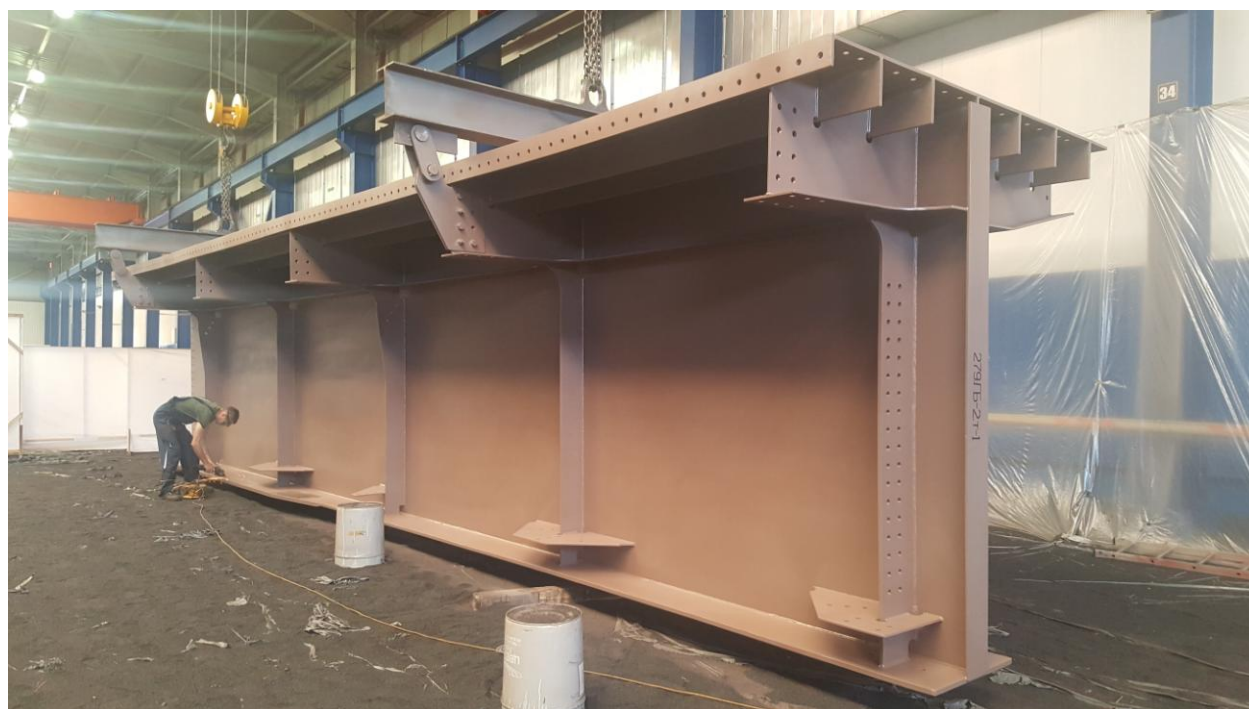
Фото №52. Крупногабаритные отправочные марки окрашиваются с предварительным укрытием стен цеха полиэтиленовой плёнкой.
