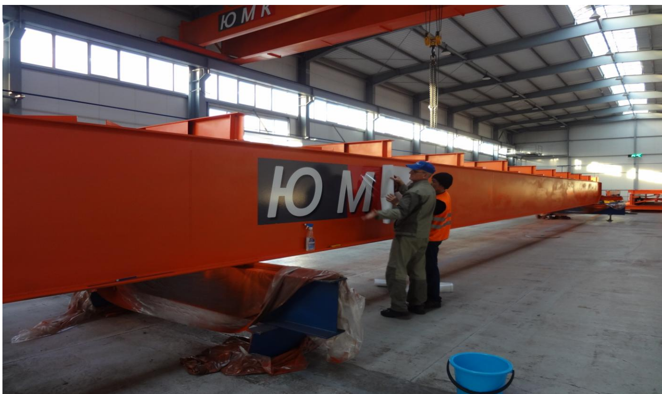
Фото №52. Окраска металлоконструкций мостового крана.
