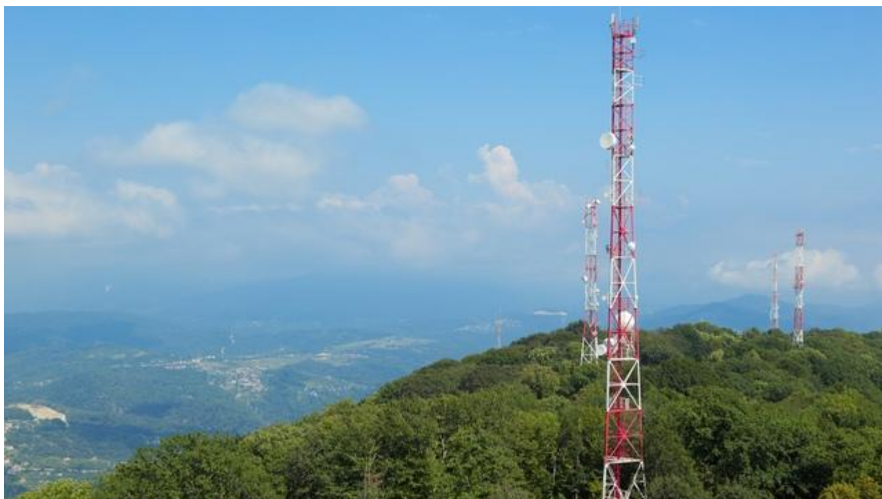
Фото №51. Вышка сотовой связи на горе Ахун в г. Сочи.
