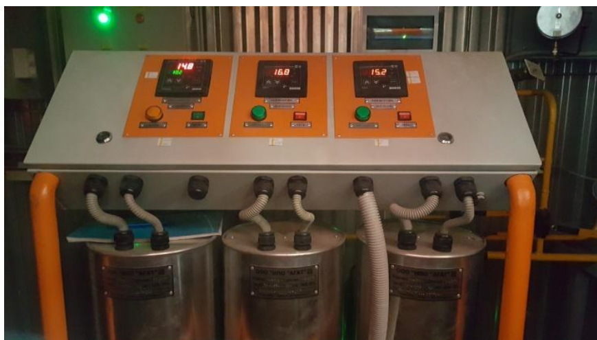
Фото №51. Газификатор подготовки сварочной смеси.
