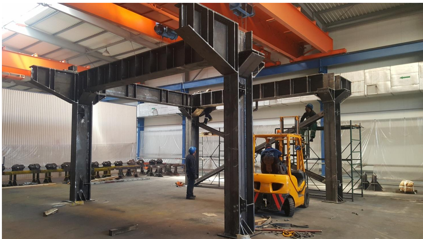
Фото №10. Контрольная заводская сборка металлоконструкций
