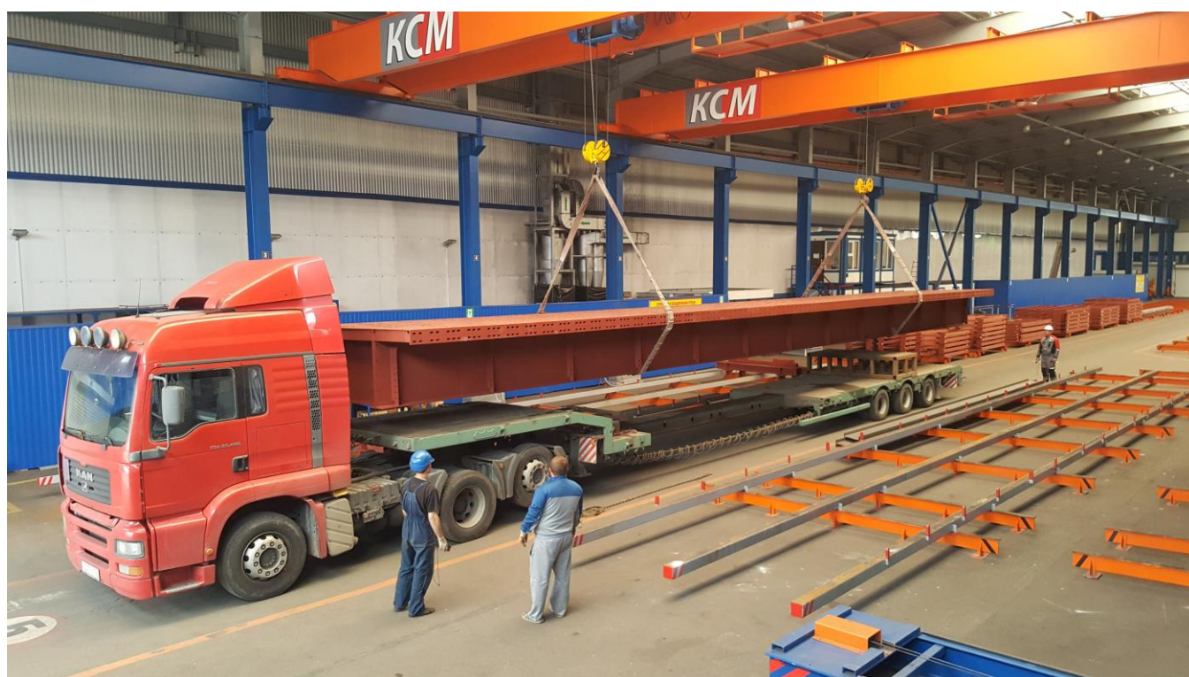
Фото №51. Погрузка длинномерной мостовой балки с помощью двух мостовых кранов.
