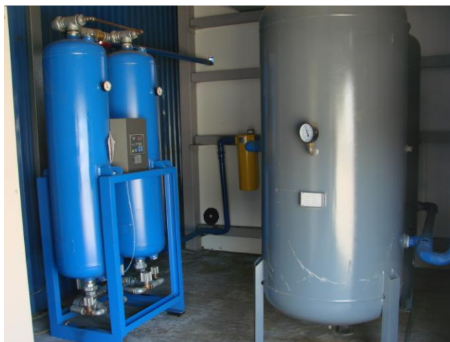
Фото №51. Система фильтрации, удаления масла и сушки сжатого воздуха.
