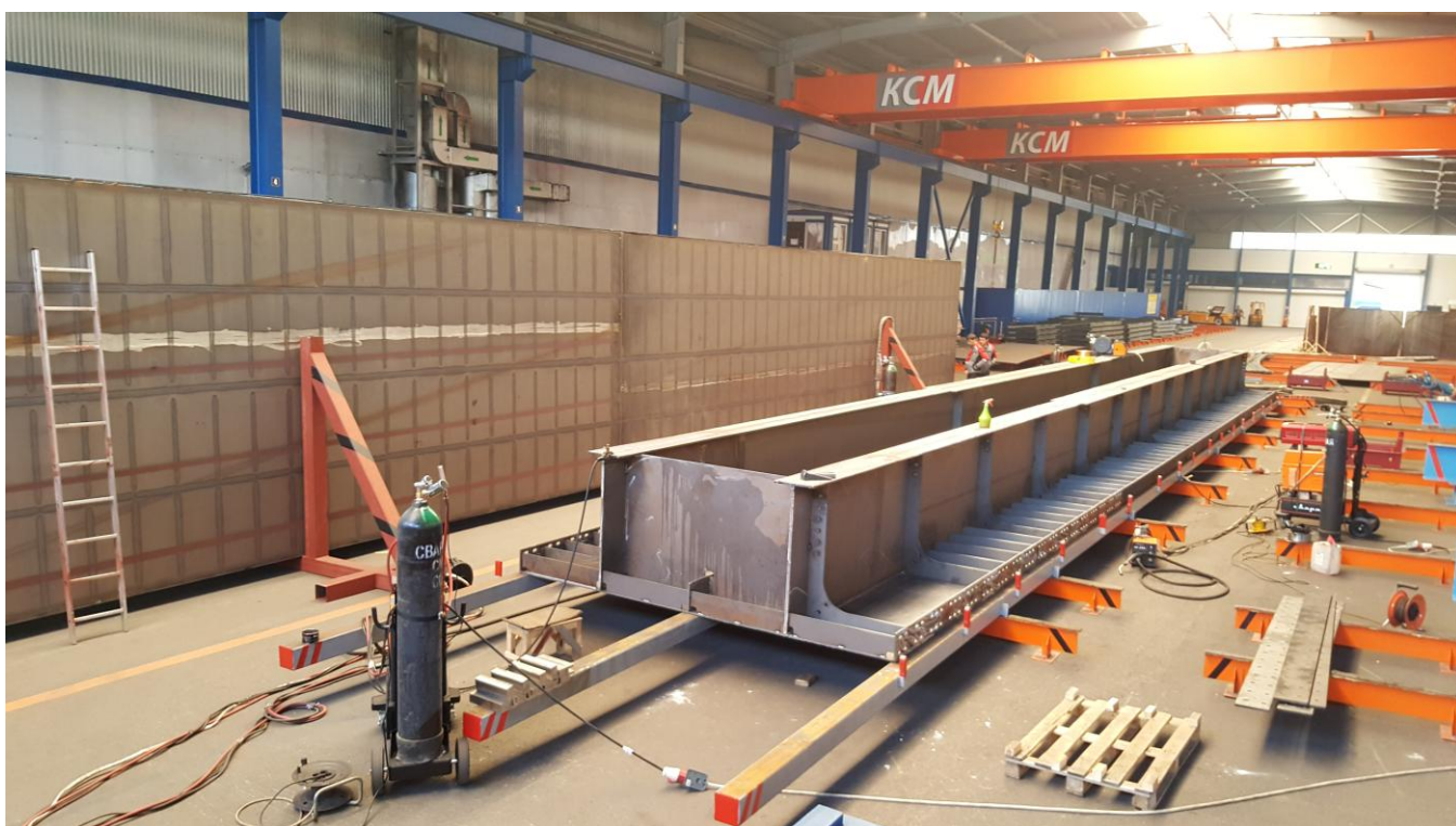
Фото №44. Для сборки и обварки габаритных мостовых металлоконструкций используются мобильные сварочные аппараты для сварки в среде защитных газов.
