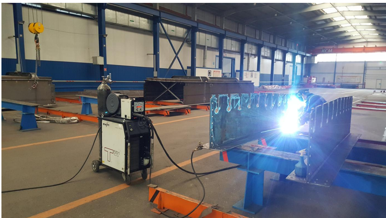
Фото №51. Сварочные работы с использованием полуавтомата EWM TAURUS 551 DW SYNERGIC S
