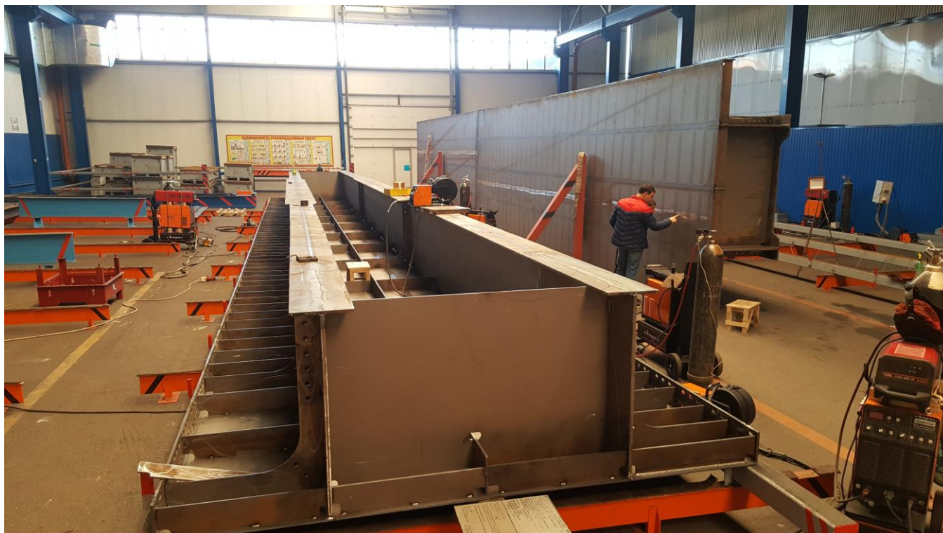
Фото №45. Контроль сварных швов осуществляется на всех этапах сварки мостовых металлоконструкций.
