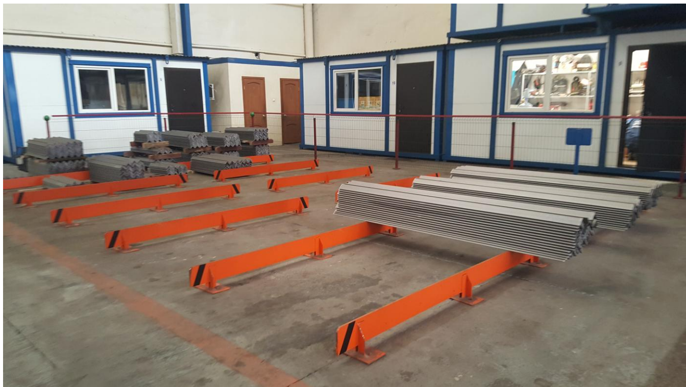
Фото №18. Раскладка заготовок фасонного металлопрокат
