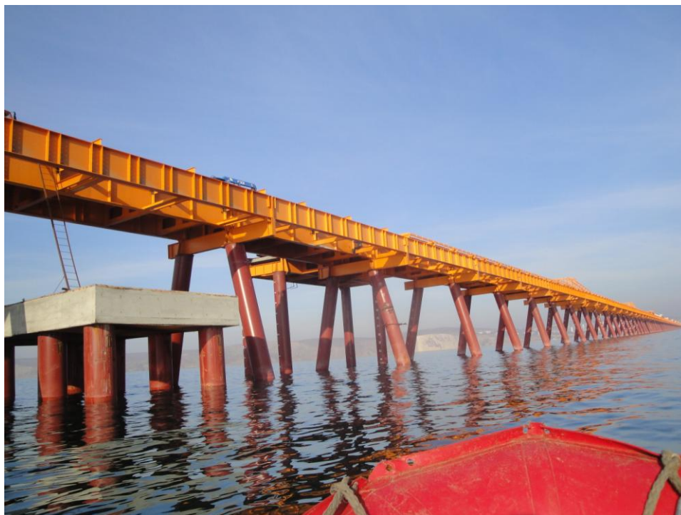
Фото №51. Морская разгрузочная эстакада в посёлке Волна (Черноморское побережье).
