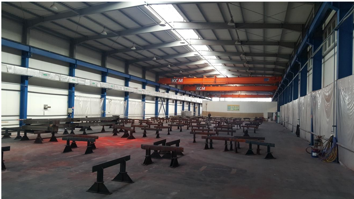
Фото №46. Первая зона цеха окраски.
