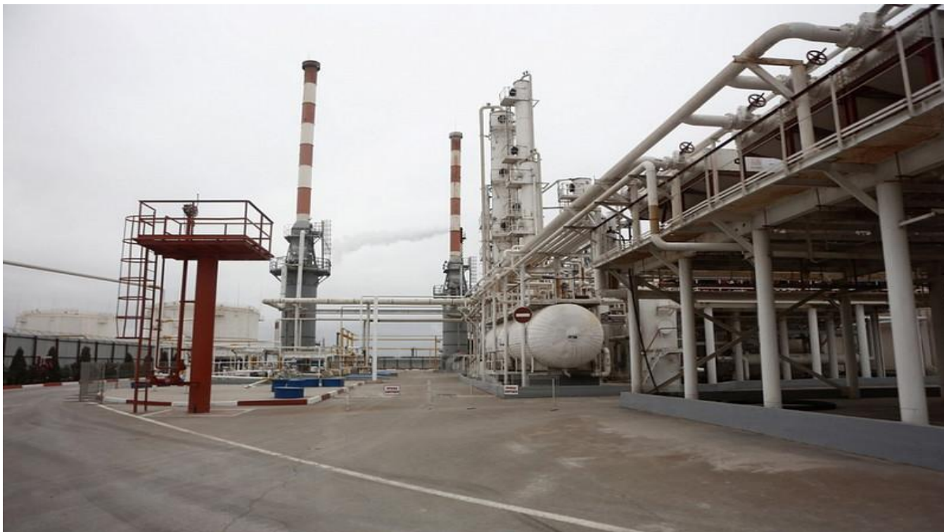
Фото №51. Славянского НПЗ (ООО «Славянск ЭКО»)
